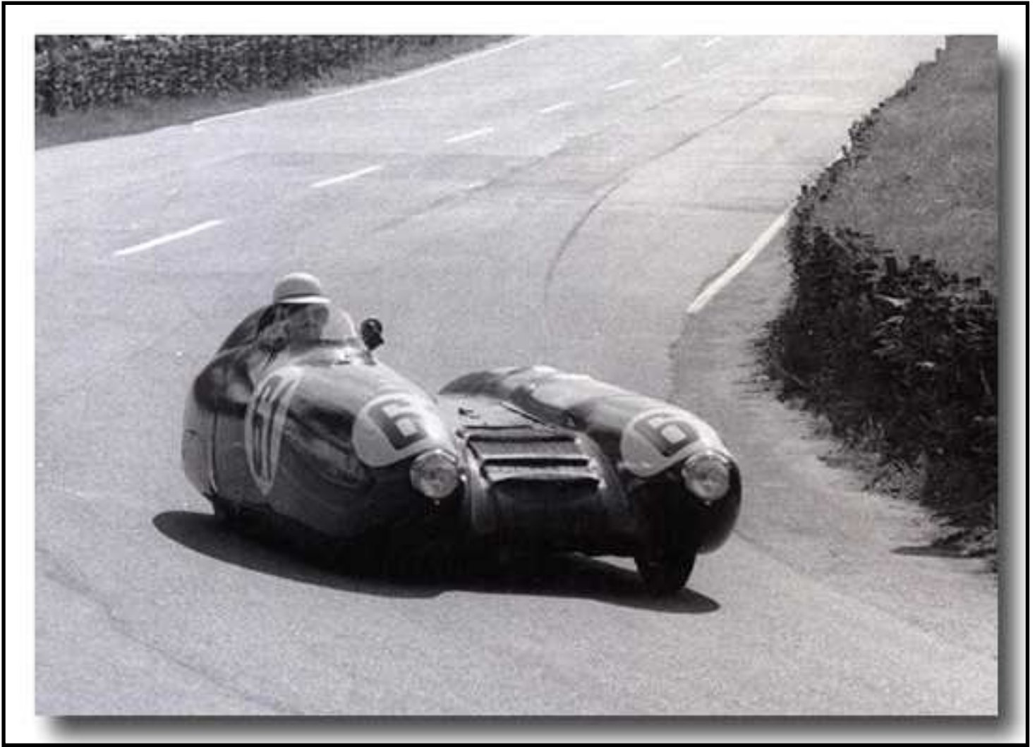
La Bisiluro au Mans. Remarquons les volets supplémentaires au-dessus du radiateur pour forcer le passage de l'air autour des tubes en laiton.
